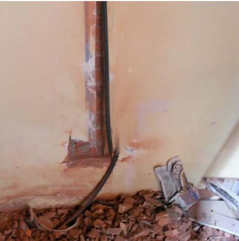
Residuos de obra generados por la ejecución *in situ* de rozas en un muro de obra de fábrica.
